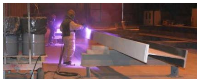
Manual metal spray zinc layer
